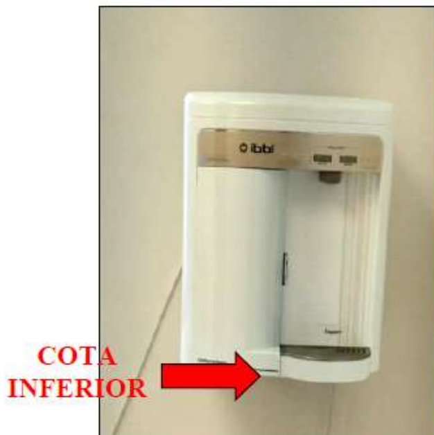
Figura 03: Posição do Purificador a ser instalado na parede.
