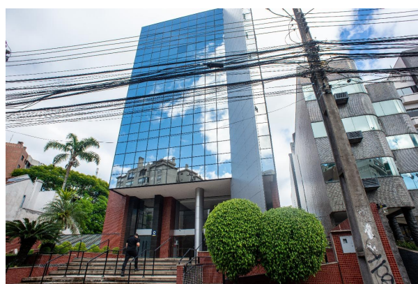
Foto 1 - Fachada do imóvel (não há adequação prevista)
