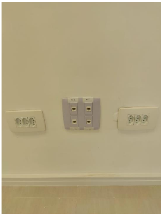
Pontos de Elétrica e Lógica embutidos em alvenaria/Dry Wall
