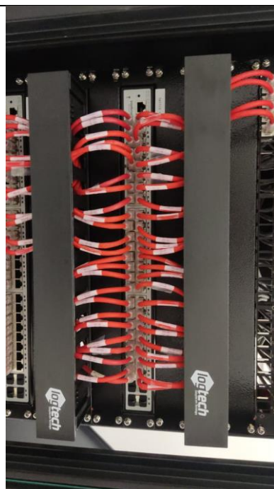
Conectorização de cabos de rede nos patch panels
