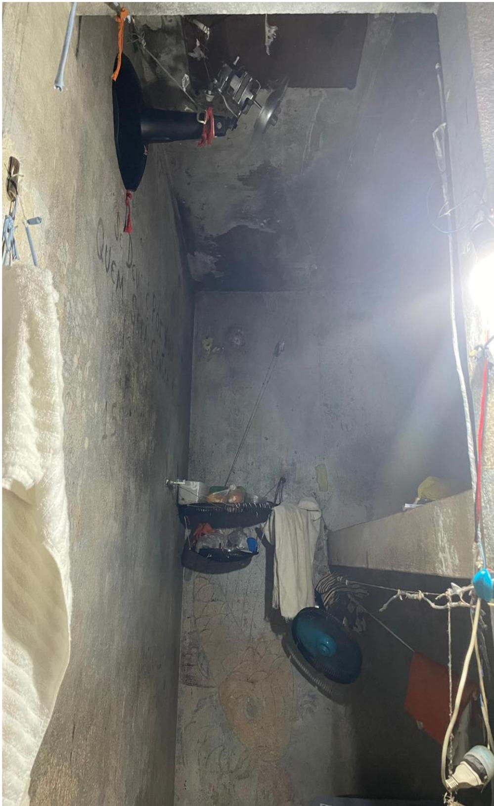
As partes em que há contato direto com a água (pias e chuveiros) continuam sem serem revestidas por azulejos ou materiais adequados a uso em ambientes úmidos. A pintura das paredes, portanto, está deteriorada nessas áreas. Há
