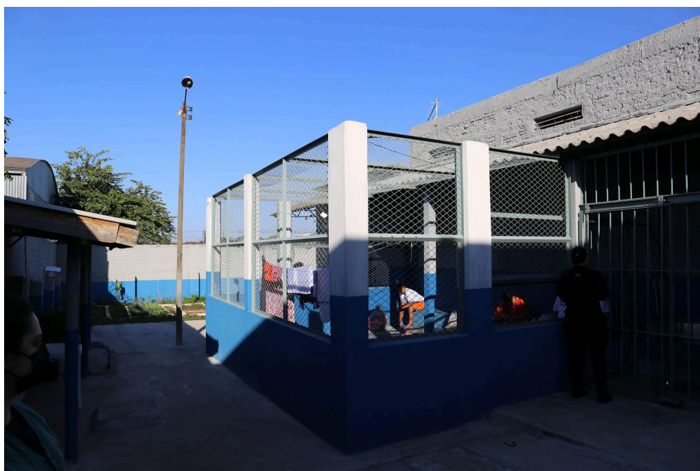
Imagem: solário implantado na galeria de trabalho.
