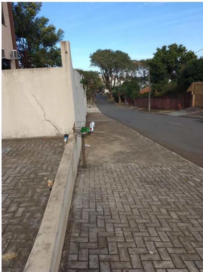
Lateral do prédio pavimentada com pavers
