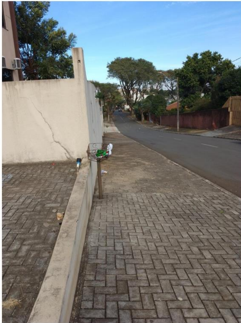
Lateral do prédio pavimentada com pavers
