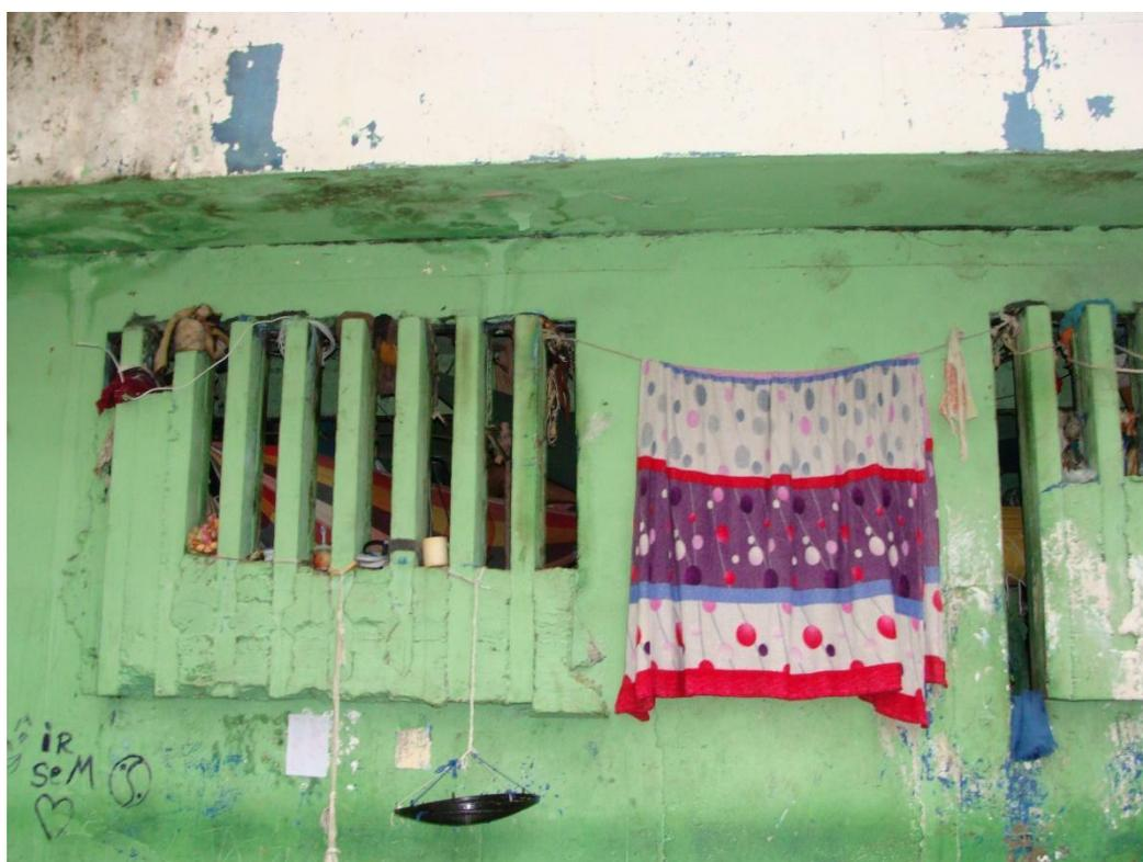
Embora não tenha sido possível adentrar a galeria para verificar as condições atuais, há um forte odor de mofo no local e é possível visualizar vários pontos de umidade no pátio que faz divisa com a galeria e infiltração nas paredes.
