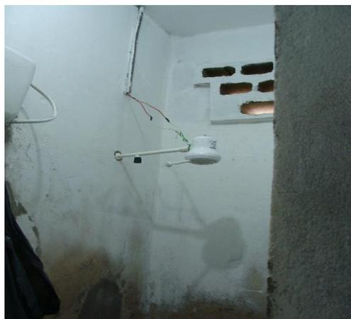
Há pouca iluminação natural nos cubículos, em alguns, apenas luz artificial. Quanto às lâmpadas, é possível observar que são todas novas e todas funcionavam. A fiação elétrica, embora aparentemente nova, está parcialmente exposta, o que torna o ambiente mais suscetível a risco de incêndios.
