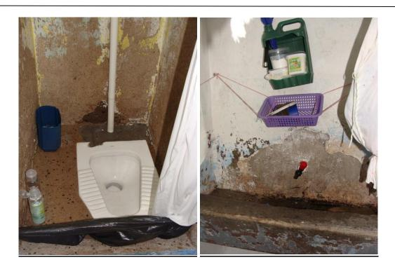
Não há iluminação natural em nenhum dos cubículos, apenas artificial. Quanto às lâmpadas, é possível observar que são todas novas e todas funcionavam. A fiação elétrica, embora aparentemente nova, está parcialmente exposta, o que torna o ambiente mais suscetível a risco de incêndios.
