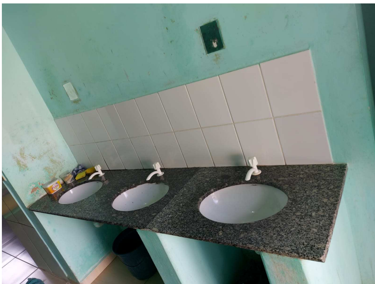
Parte externa dos banheiros do alojamento.
