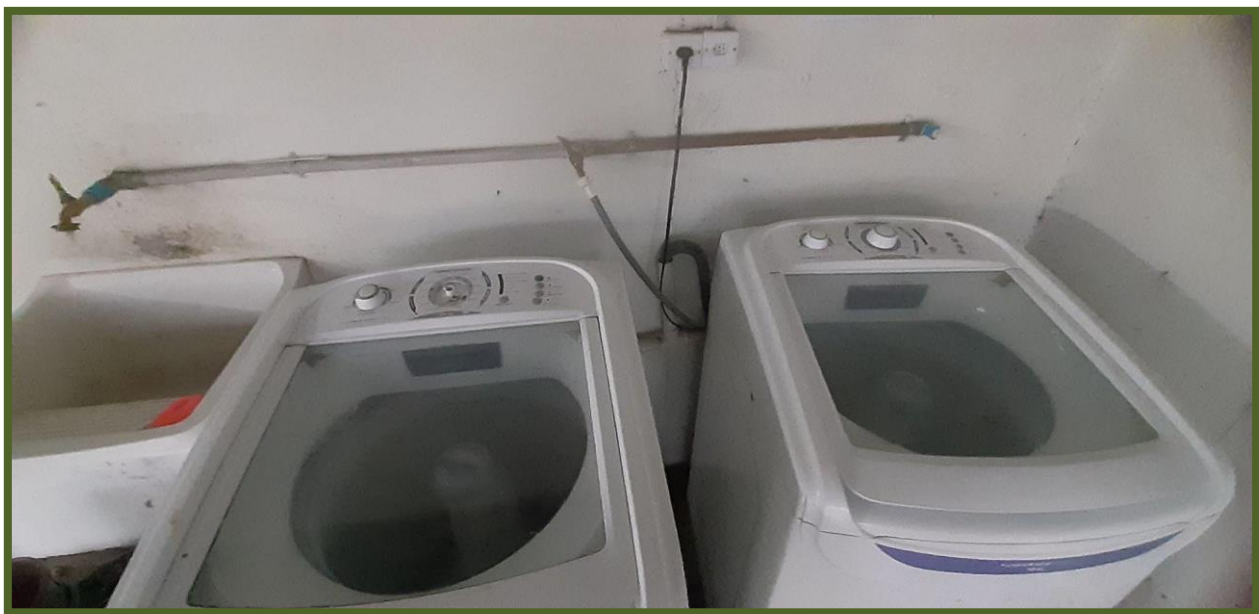
Figura 10 - Lavanderia Fotografada na UAI Cajuru.
