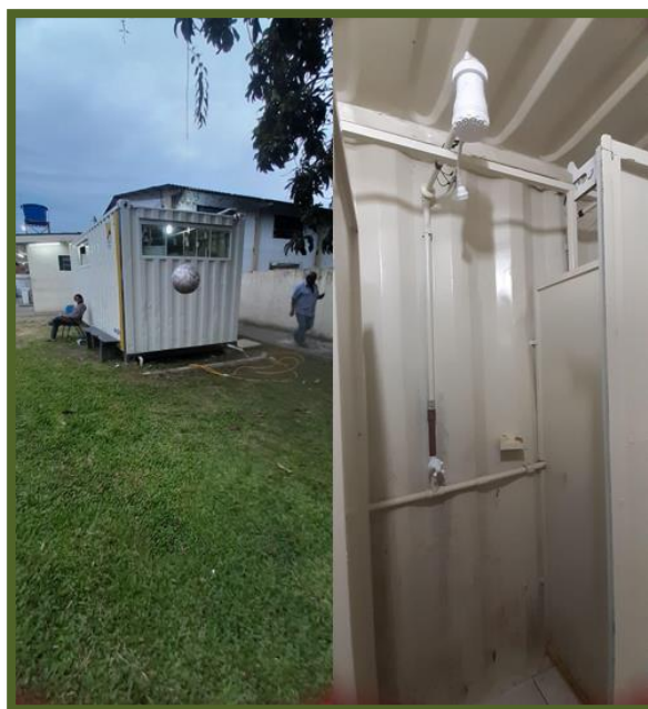
Figura 9 - Estrutura de Container Utilizada como Banheiro na UAI Cajuru.
