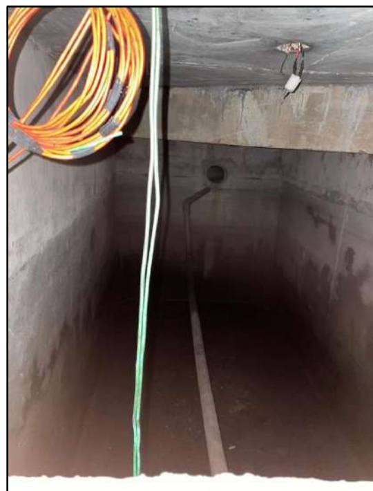
Figura 11: Cisterna da Sede Núcleos, EDEPAR e Corregedoria-Geral da DPE.
