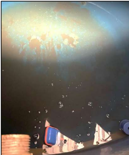
Figura 4: Caixa D'Água P/Consumo Sede Central de Atendimento.
