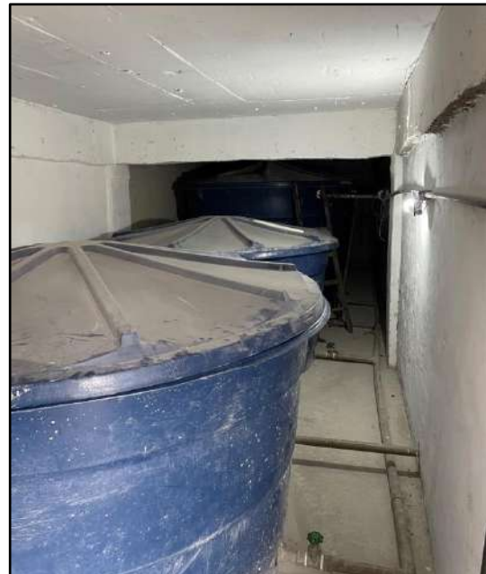
Figura 3: Caixa D'Água P/Consumo Sede Central de Atendimento.
